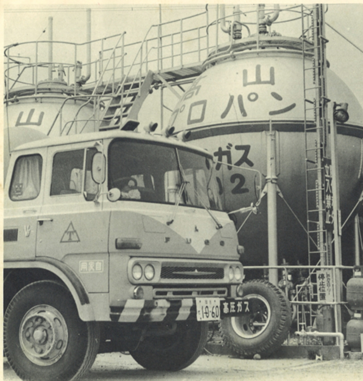
岡山市福浜のL.Pガス充填工場
